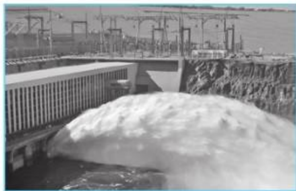
Дамба — сооружение на реке
