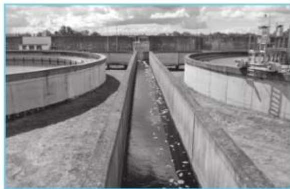
Очистные сооружения на канале
