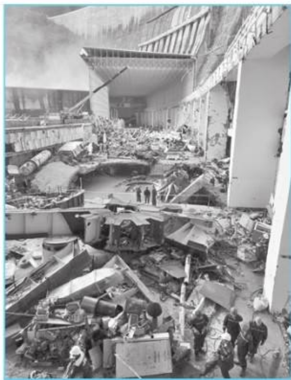
Авария на электростанции
